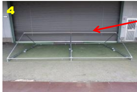
4. 桁、棟のパイプを差し込んで、ジョイントします。
