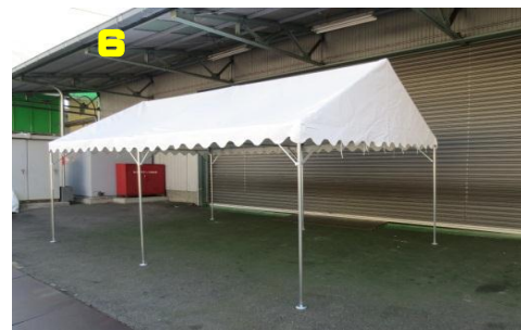
6. 筋交を固定して完成。
